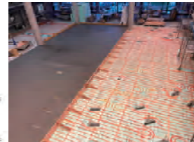
【床放射空調の施工状況】
