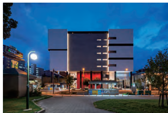
北棟夜景：分節されたボリュームが積層することで、まちへの圧迫感を低減
