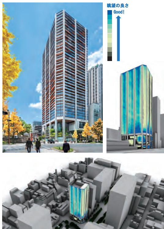
「ビューポテンシャル」の可視化によるフィン配置の最適化
