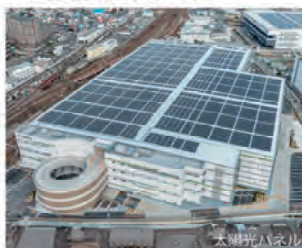
太陽光パネル
