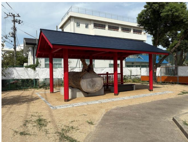
完成した古堤街道周遊休憩所「大クスの館」(大東市泉町)
