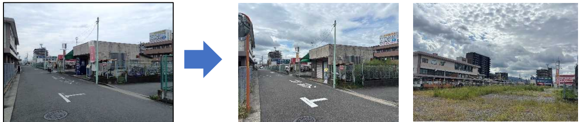
四条畷駅西側立体駐輪場の整備（駐輪場の立体化） 整備前 整備状況
