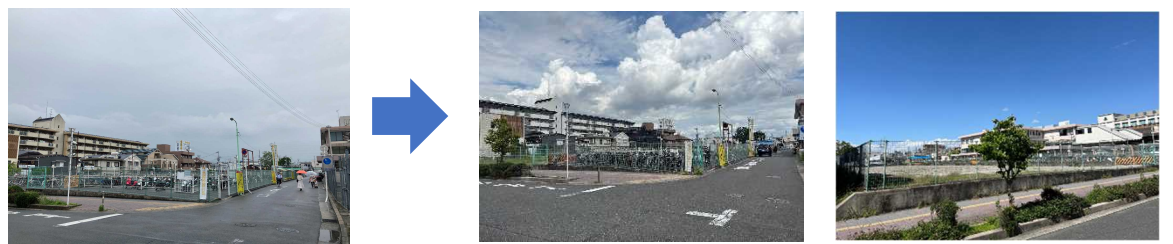
四条畷駅西側駅前広場の整備（広場・ロータリーの設置） 整備前 整備状況
