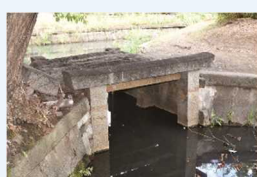
かみなり樋門（深野南町）
