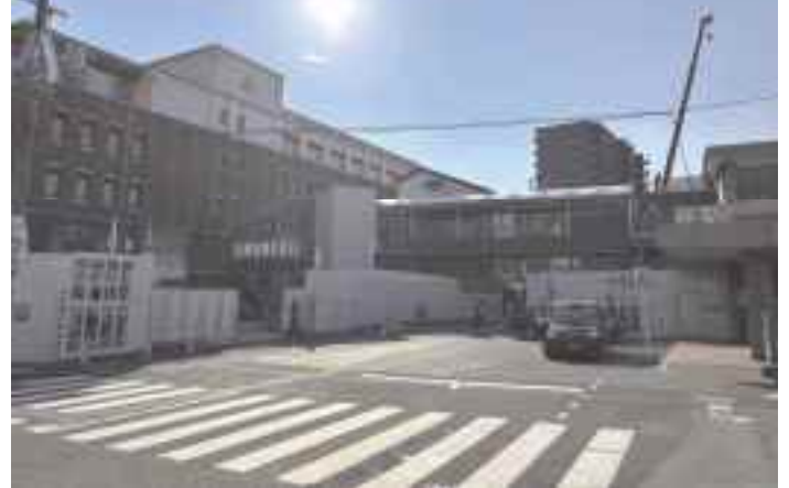
ペDESTリアンデッキ 写真（整備中）
