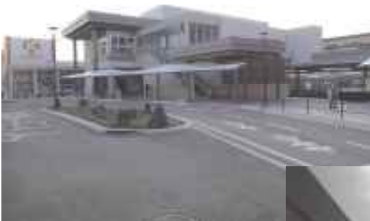
野崎駅東側駅前広場・橋上駅舎
