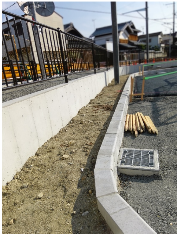
写真-8 現場施工状況⑧
