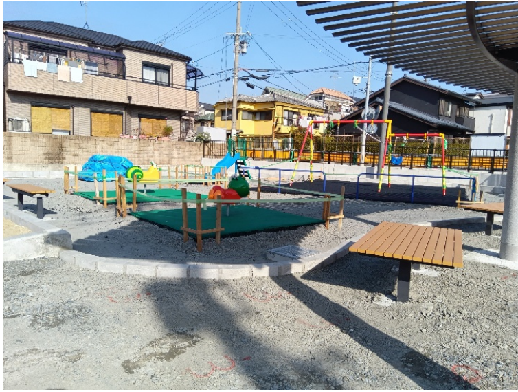
写真-6 現場施工状況⑥
