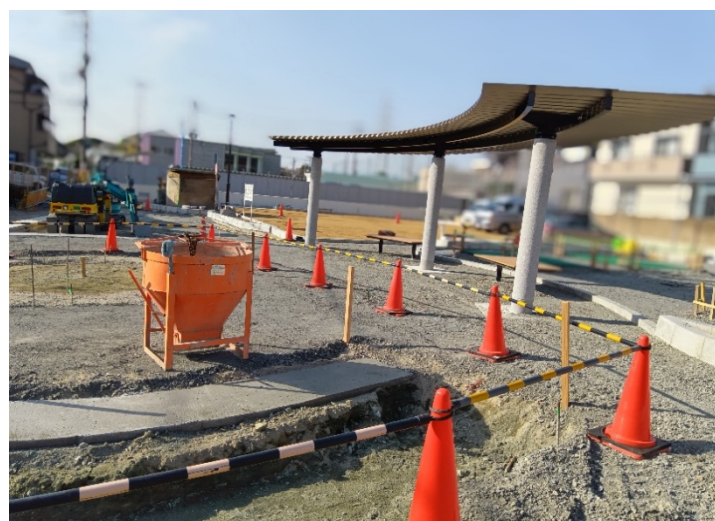
写真一 5 現場施工状況⑤
