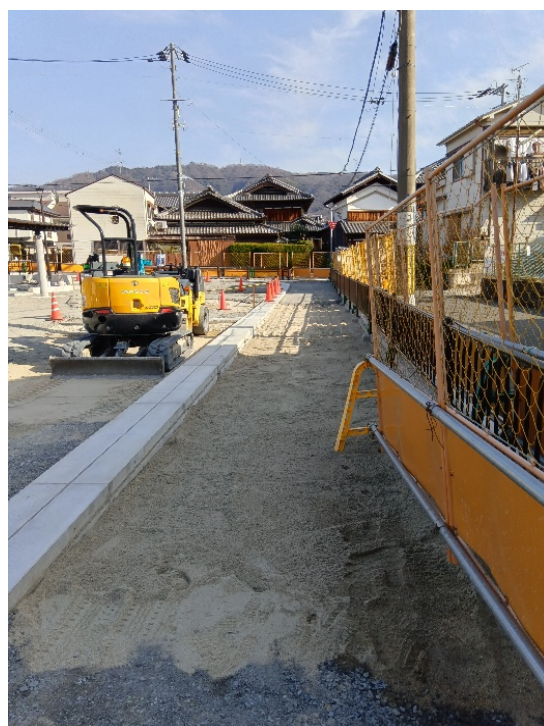
写真一 4 現場施工状況④
