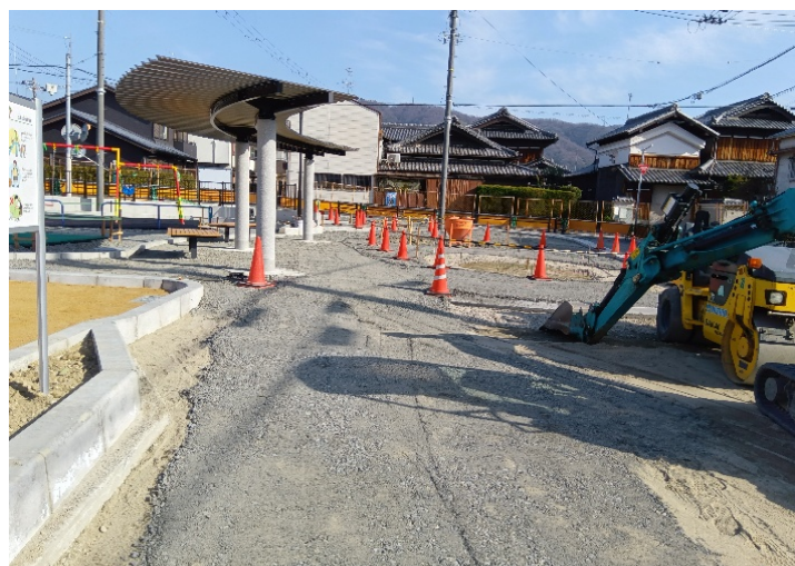
写真一 3 現場施工状況③
