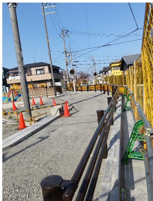
写真一 2 現場施工状況②
