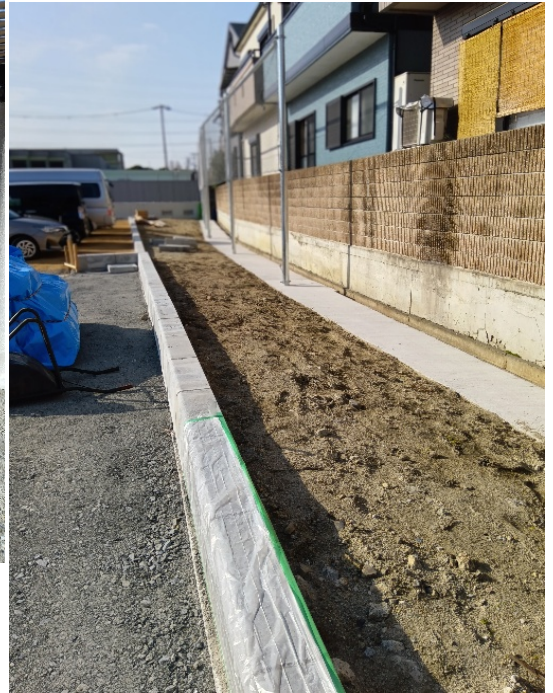
写真-7 現場施工状況⑦
