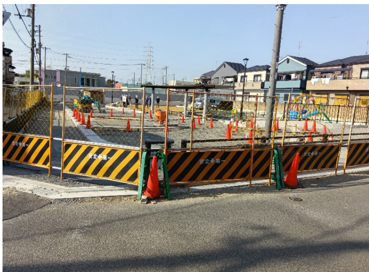
写真一 1 現場施工状況①
