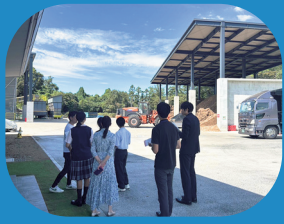
株式会社BPSI 1こま 北田原発電所 (令和7年8月22日)
