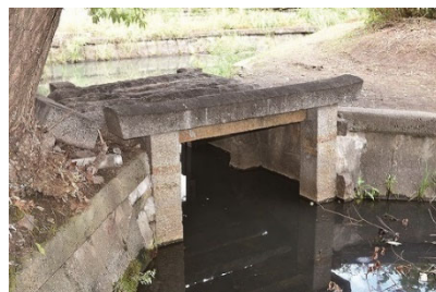
かみなり樋門
