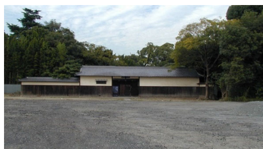
解体前の平野屋新田会所
