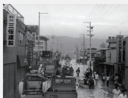
昭和47年（1972）7月豪雨（大東水害）
