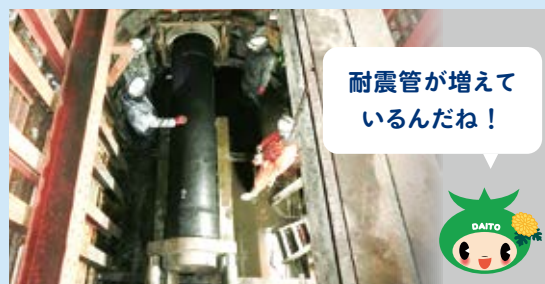
〈耐震管への更新工事の様子〉
