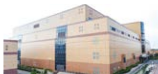
大阪広域水道企業団 村野浄水場
