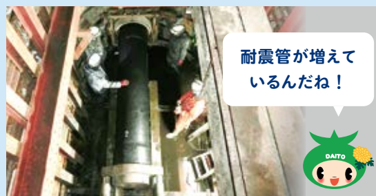
〈耐震管への更新工事の様子〉
