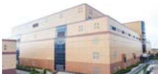
大阪広域水道企業団 村野浄水場
