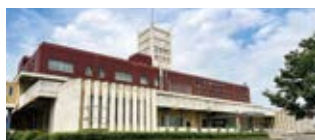
大阪府 川俣水みらいセンター
