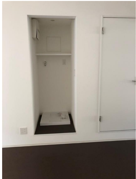
室内洗濯機置場
