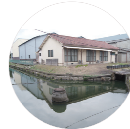
かみなり樋門
