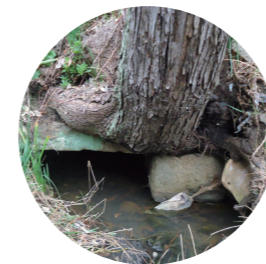
どんばの伏越樋
