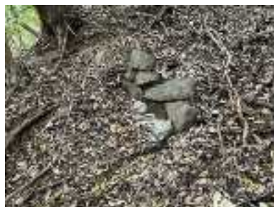
図 117 ほとんど残存していない 石垣(石垣 27)
