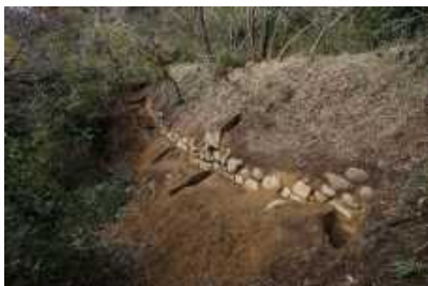
図 45 VIII郭(千畳敷郭)曲輪 112 石垣 88 第18-9 トレンチ
