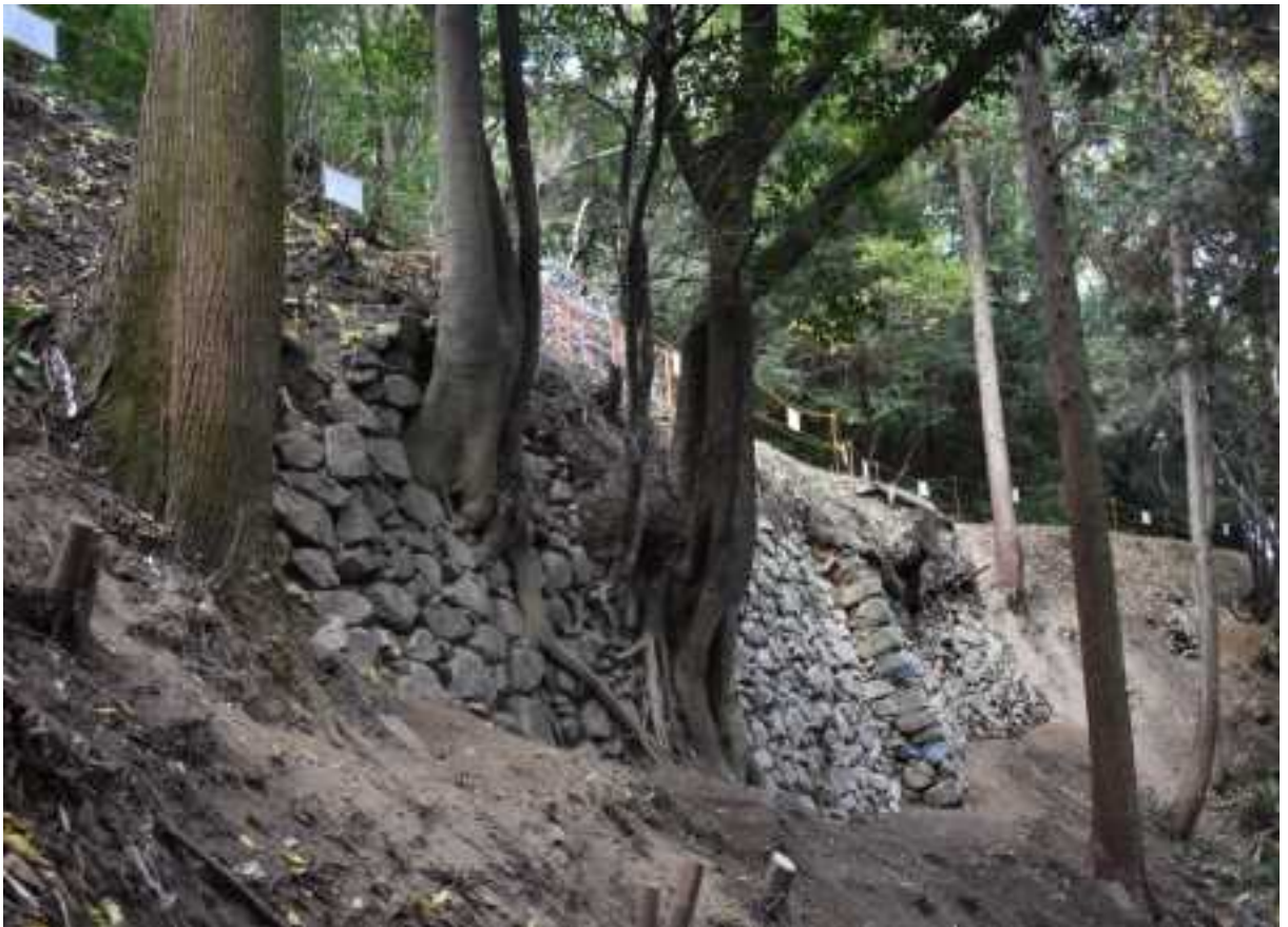
巻頭図 2 石垣 69 全景 南東から
