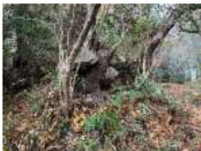
図 116 ほぼ崩壊している石垣 (石垣 71)
