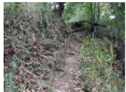
図 136 土砂流出の進む登山道
