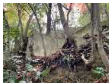
図 151 史跡指定地内にある擁壁
