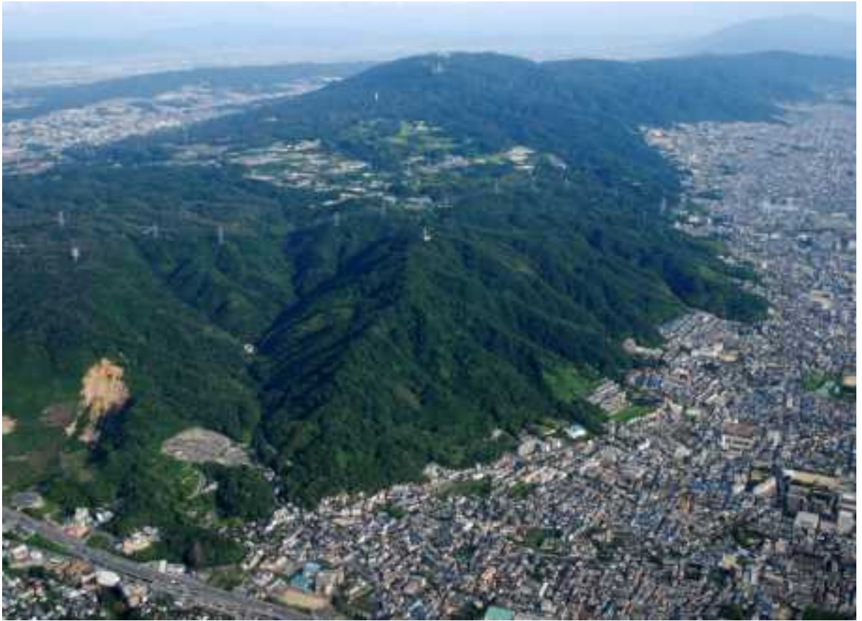
巻頭図 1 飯盛城跡遠景(俯瞰) 北西から
