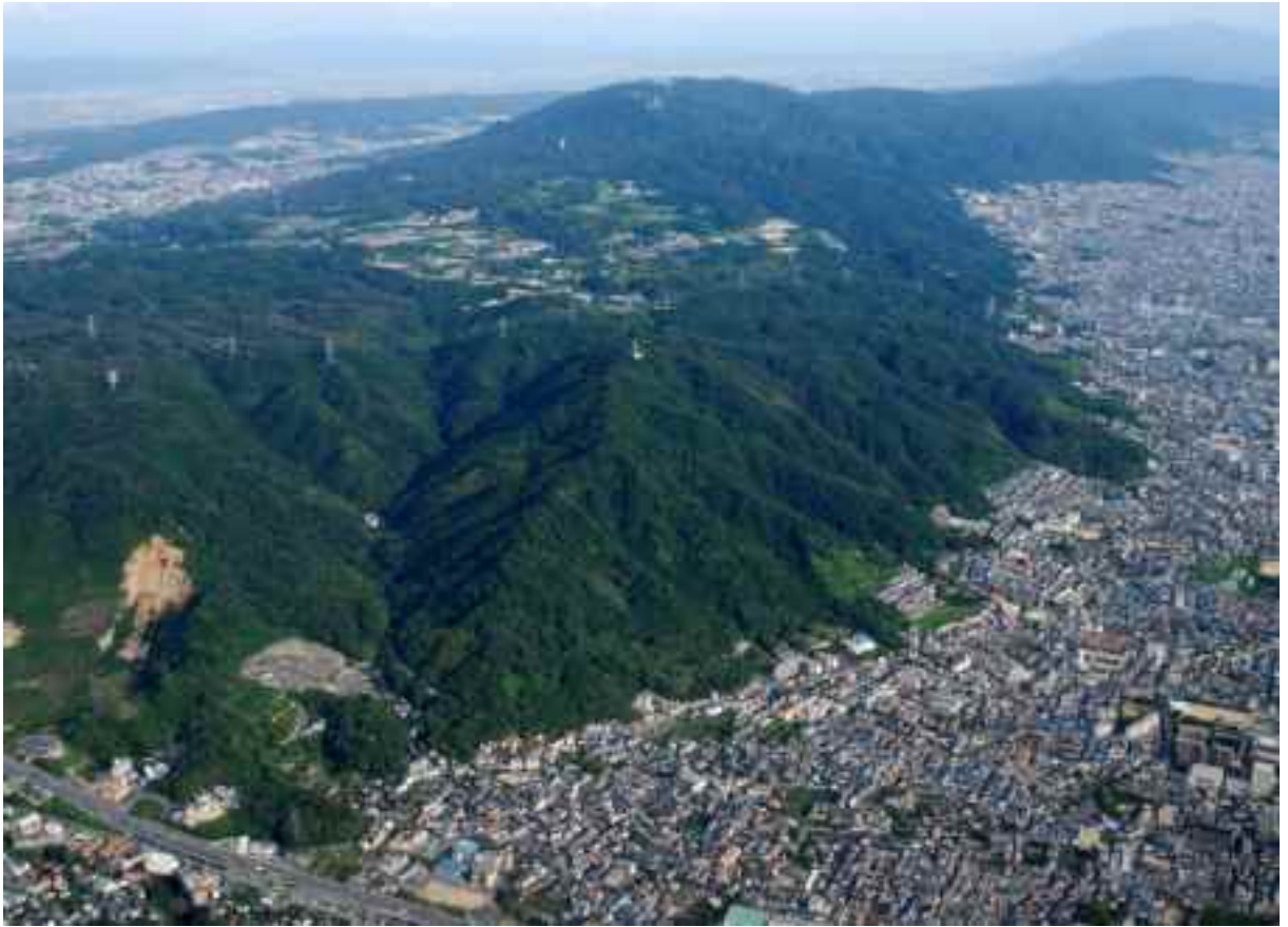
巻頭図 1 飯盛城跡遠景(俯瞰) 北西から
