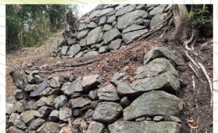
III郭西の法面にはセットバックを設けた 二段の石垣が見られます。技術的に高く築 けなくとも高く見せる工夫です。
