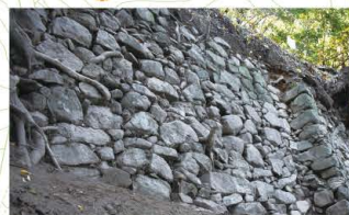
II郭の東側には、帯郭(登山道)を支える城内最大級 の石垣があります。強度を保つために隅角部を設けて います。危険な場所なので現在は立入禁止です。
