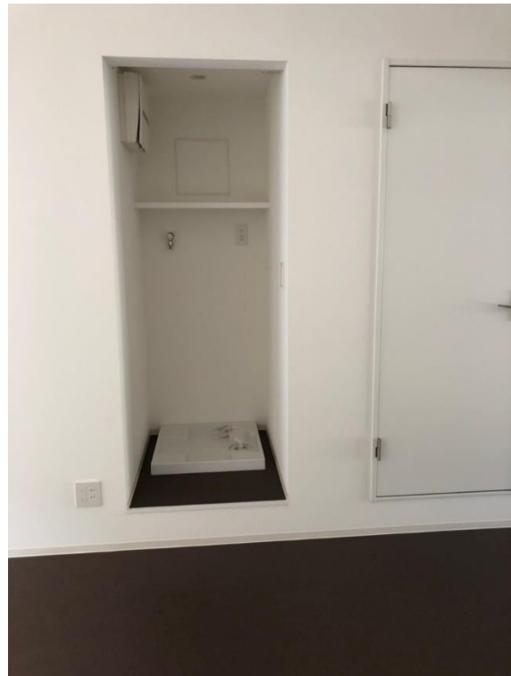
室内洗濯機置場
